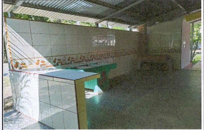
Foto 4: mejoramiento en cocina de leña, fundicion de desayunador y colocacion de azulejo
