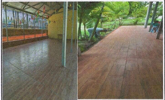
Foto 2: fundicion de Gradas en area de usos multiples y rampa para bajar al area de usos multiples
